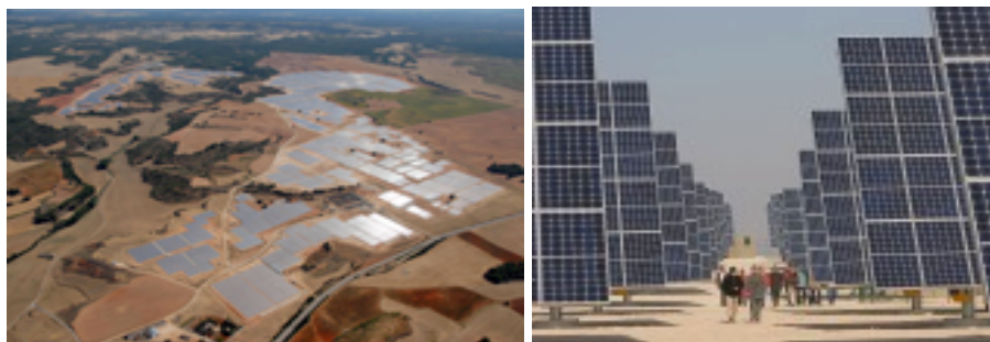
Slika 10. Najveća realizovana FN solarna elektrana na svetu - Olmedilla de Alarcón u Huerta Solar Citruenigo u Španiji (izvor: Acciona Energia)
